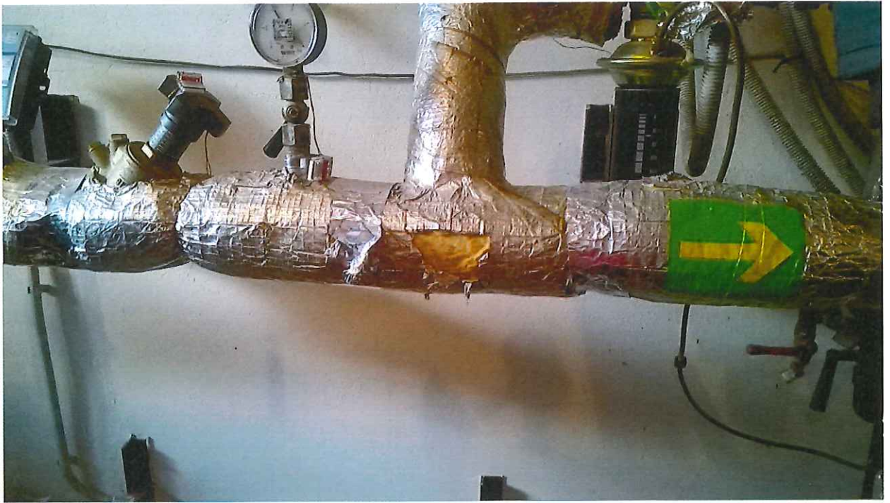
12 pav. Šiluminiame mazge nuplėšta vamzdį dengiančios vatos izoliacija
